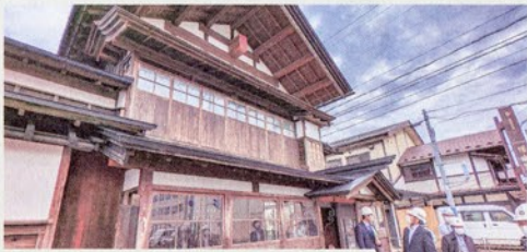
今春公開される旧松倉家住宅 芸術文化振興議連で工事現場を視察
